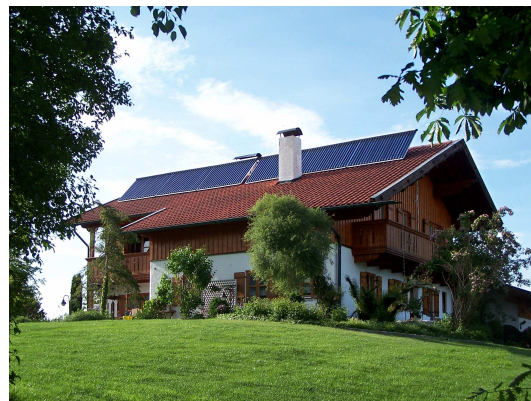
Wohnhaus mit Bürofläche (2005): 1,5 m 3 Puffer + 26 m 2 Kollektorfläche
