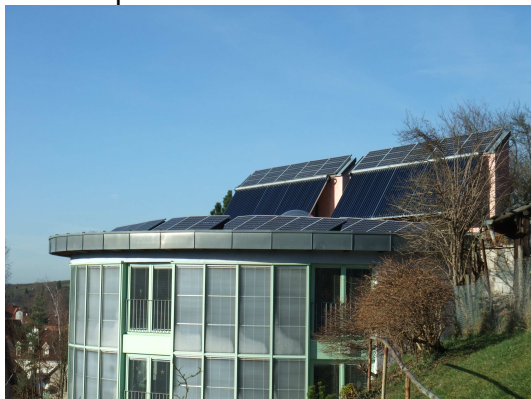
Passiv-Einfamilienhaus (2009): 0,8 m 3 Aqua Espresso + 26 m 2 Kollektorfläche
