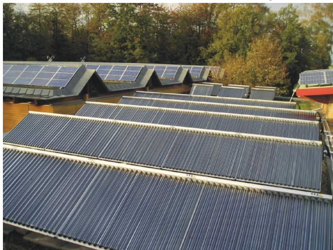
Bild 4: Heißstart-Testanlage (2007): 2 m 3 Pufferspeicher + 196 m 2 Kollektorfläche
