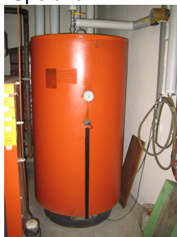
Bild 7 Industriebetrieb (2007): 500 Liter WW-Peicher + 20 m² Kollektorfläche
