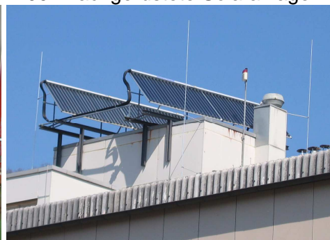
Bild 7 Industriebetrieb (2007): 500 Liter WW-Peicher + 20 m² Kollektorfläche
