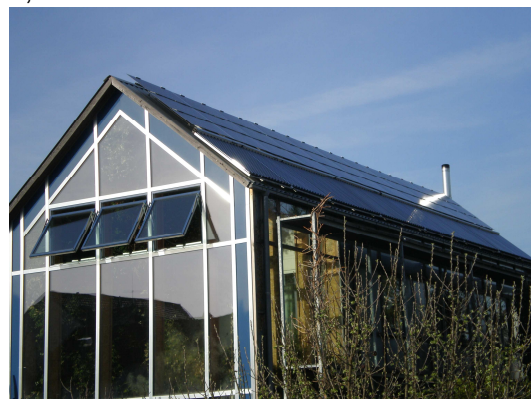
Passiv-Einfamilienhaus (2000): 2,2 m 3 Optima Power Isoplus + 27 m 2 Kollektorfläche
