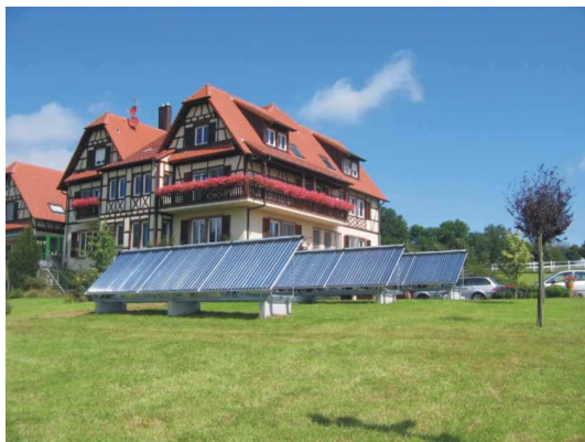
Einfamilienhaus (2007): 1 m 3 Puffer- + WW-Speicher + 44 m 2 Kollektorfläche
